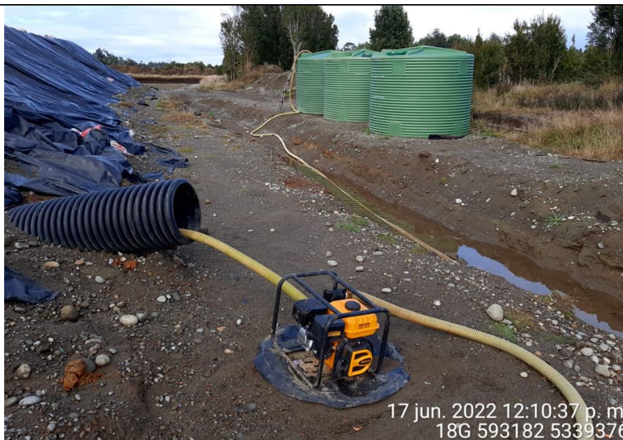
Fotografía N°10: Extracción de Lixiviados desde cámara C12. Tomada: Viernes 17 de Junio del 2022.
