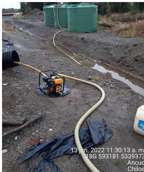
Fotografía N°1: Extracción de Lixiviados desde diagonal D02. Tomada: Lunes 13 de Junio del 2022.
