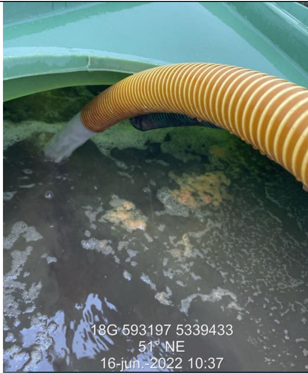
Fotografía N°9: Extracción de Lixiviados a estanque por personal municipal. Tomada: Jueves 16 de Junio del 2022.
