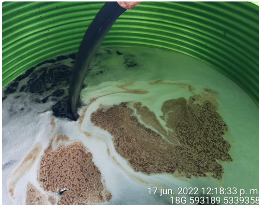
Fotografía N°11: Extracción de Lixiviados a estanque. Tomada: Viernes 17 de Junio del 2022.
