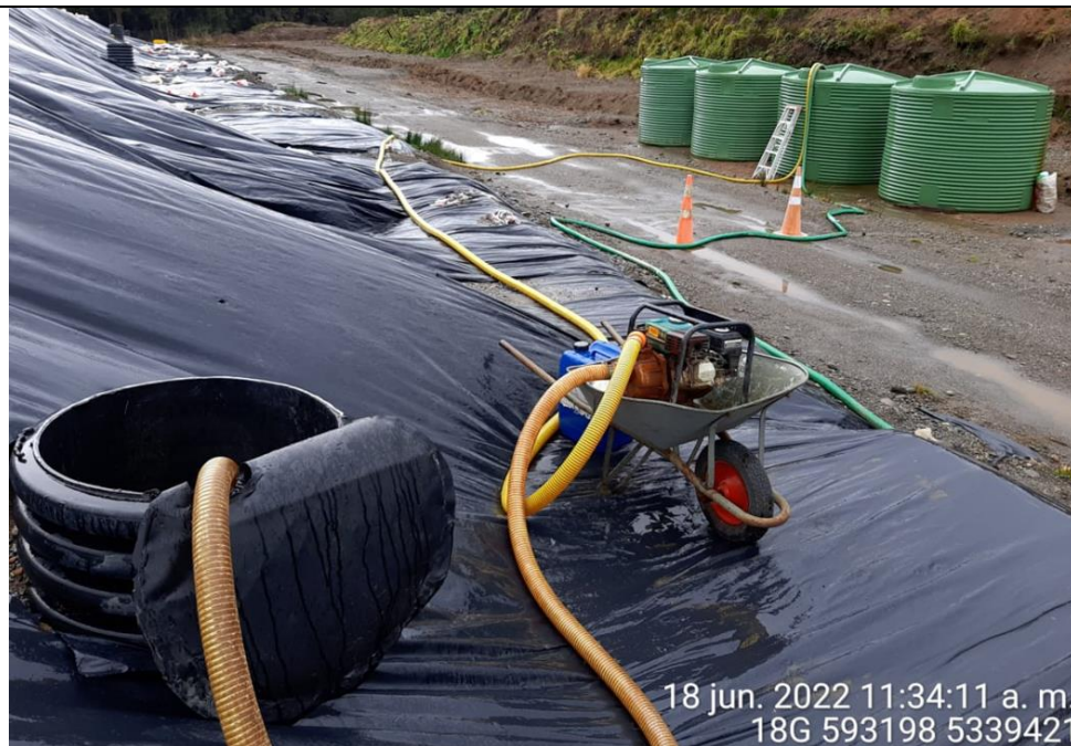
Fotografía N°12: Extracción de Lixiviados cámara C13. Tomada: Sábado 18 de Junio del 2022.
