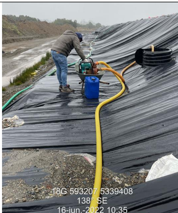
Fotografía N°8: Extracción de Lixiviados Cámara C13. Tomada: Jueves 16 de Junio del 2022.
