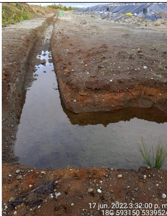
Fotografía N°25: Estado canales aguas lluvias
